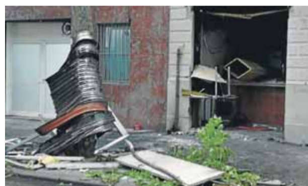
La casa afectada, amb el bar destruït i la persiana metàl·lica enrotllada a un arbre després de trencar-se per l'explosió ■ JP
