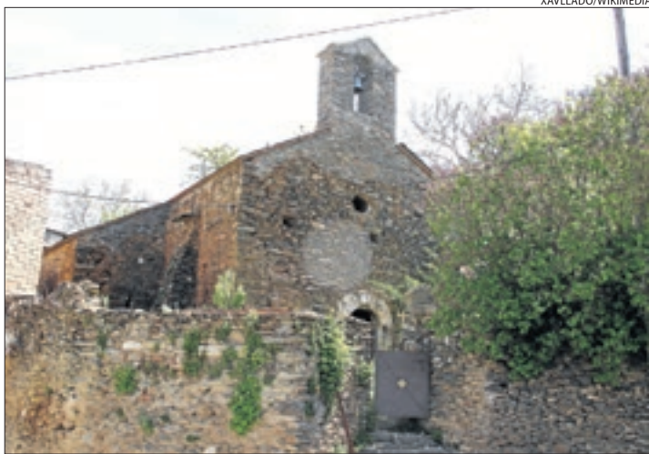
Vista de Beraní, un dels nuclis on es faran les obres.
